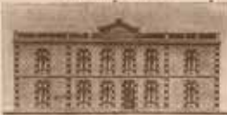
Edificio de Obras Públicas
