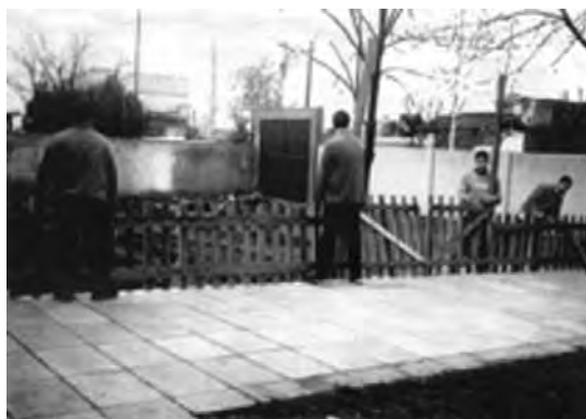
Fig. N° 14 Medición y colocación cerco y tranquera
