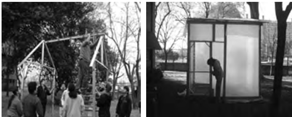
Figs. N° 12 y 13 Construcción del Invernadero dentro de la Escuela
