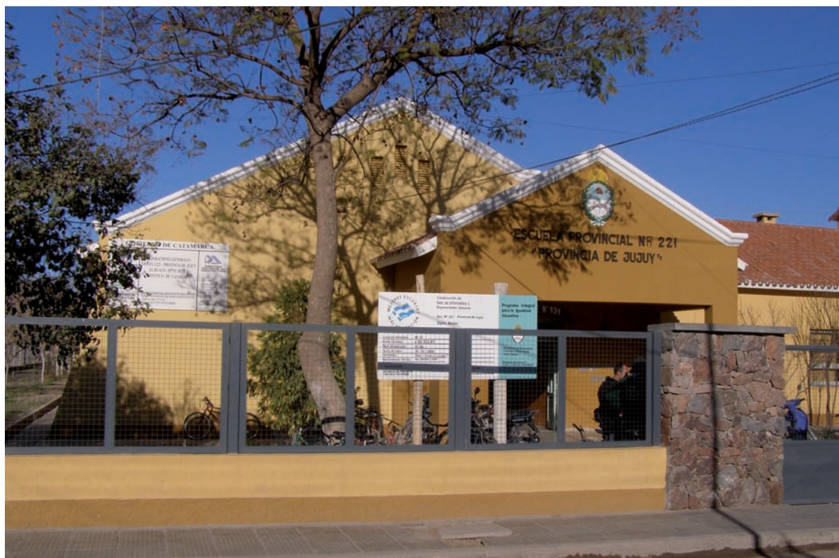
Escuela N° 221 Provincia de Jujuy - Huaco. Dpto. BELEN. Fuente: Subsecretaría de Infraestructura Pública.
