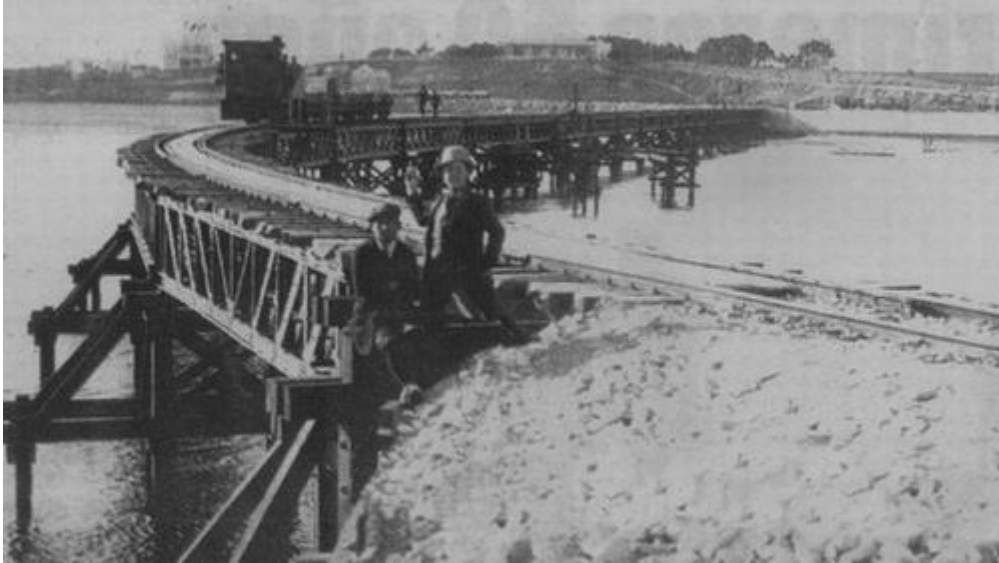
Figura 11. Obras del puente carretero del Puerto. (Gran Libro del Milenio, Ecos Diarios).
