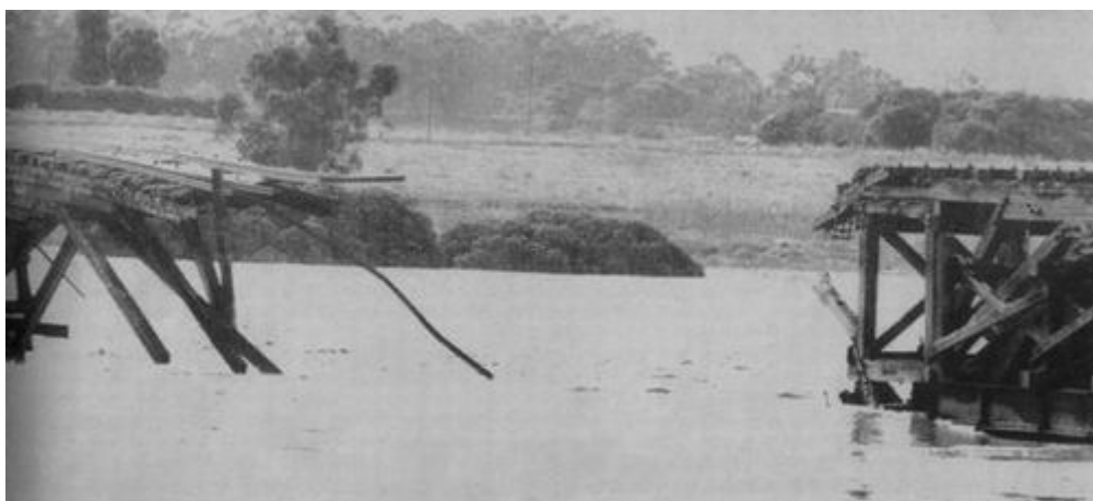
Figuras 9. El puente ferroviario destruido por la crecida del río, en 1980. (Ecos Diarios, Gran Libro del Milenio).
