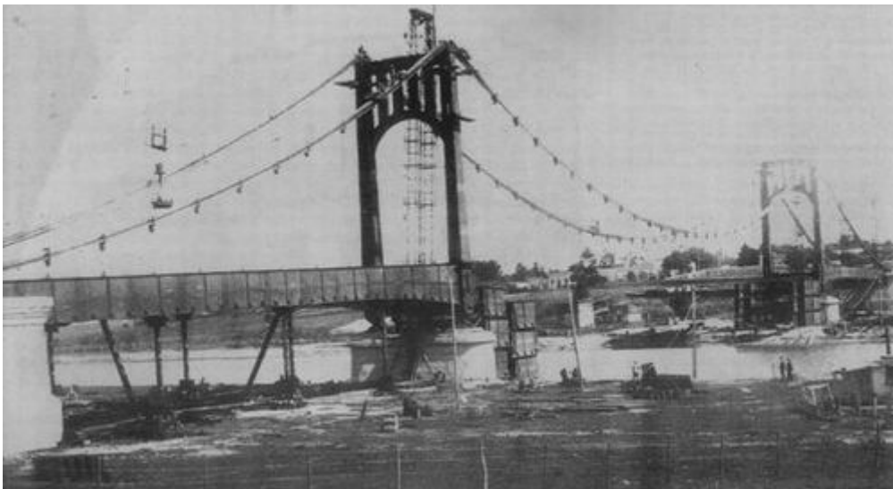
Figura 12. Construcción del puente colgante, en tres secciones que completan 270 metros de longitud. (Gran Libro del Milenio, Ecos Diarios).
