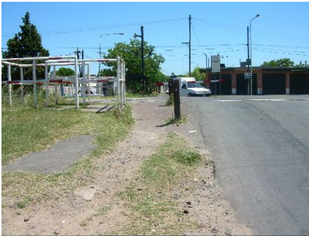
Las barreras son de funcionamiento automático y poseen señal fonoluminosa. El paso a nivel cuenta con un sendero para el cruce peatonal con protección laberinto.
