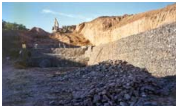
Obra de protección de erosión en la cárcava del Arroyo El Gato – Provincia de Córdoba
