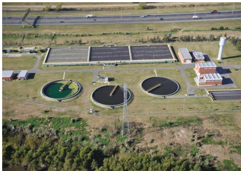
Hurlingham. Nueva Planta de Tratamiento de líquidos cloacales y redes colectoras y colectores.
