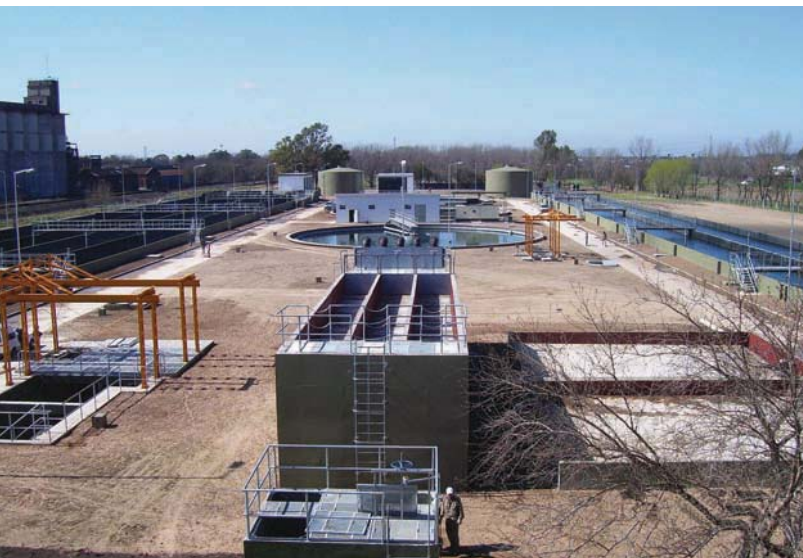
San Miguel. Rehabilitación y ampliación de la Planta de Bella Vista y ampliación de redes.
