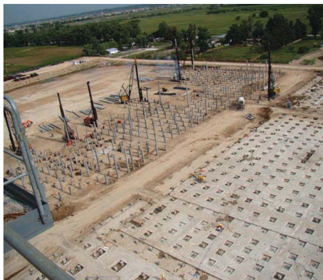
Plata de fondo de la reserva de agua potable del módulo N° 2, y pilotes aún no descabezados.
