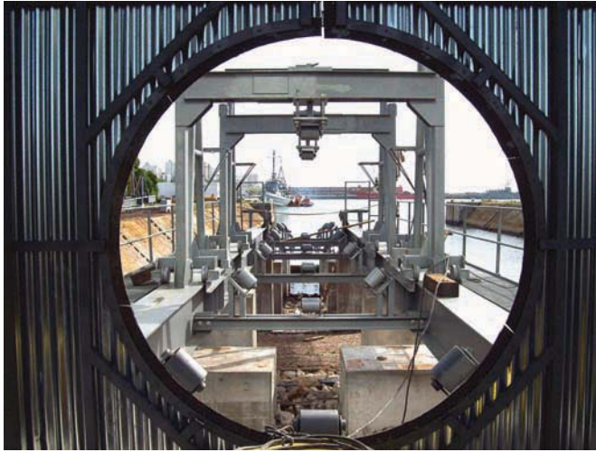
Instalación. Obras en tierra. Intallation. Works on land.
