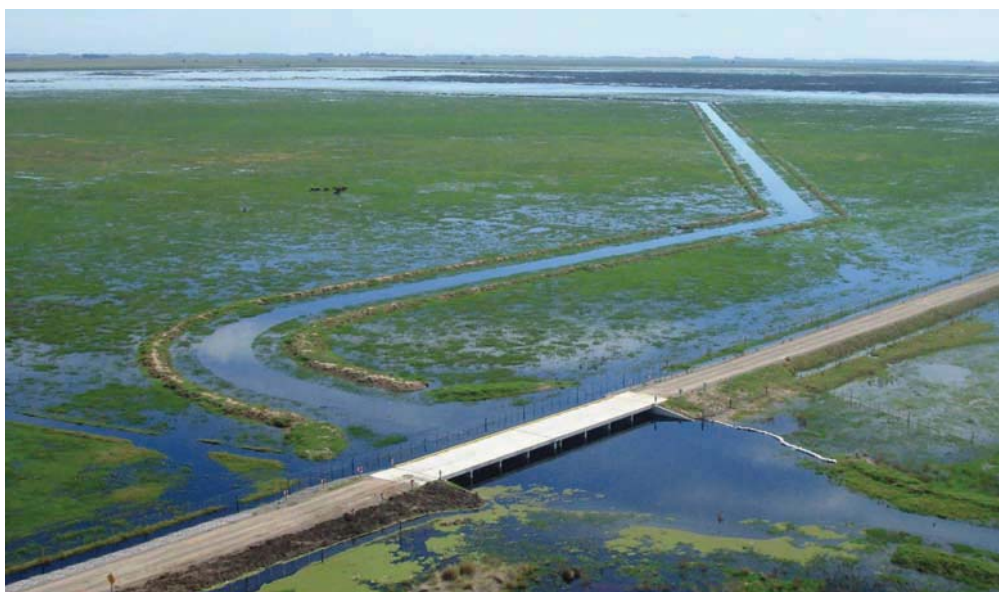
Obras en la Subcuenca A-1 de las nacientes del Río Salado. Obra de regulación N°5-La Picasa".
