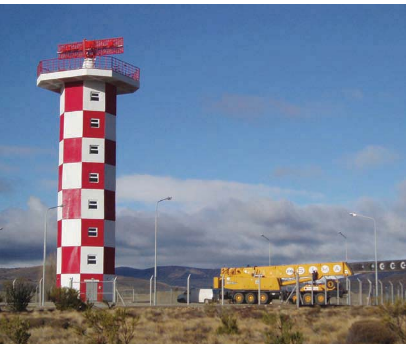
Aeropuerto Internacional de Bariloche. Antena montada y grúa. Bariloche International Airport. Mounted antenna and crane.
