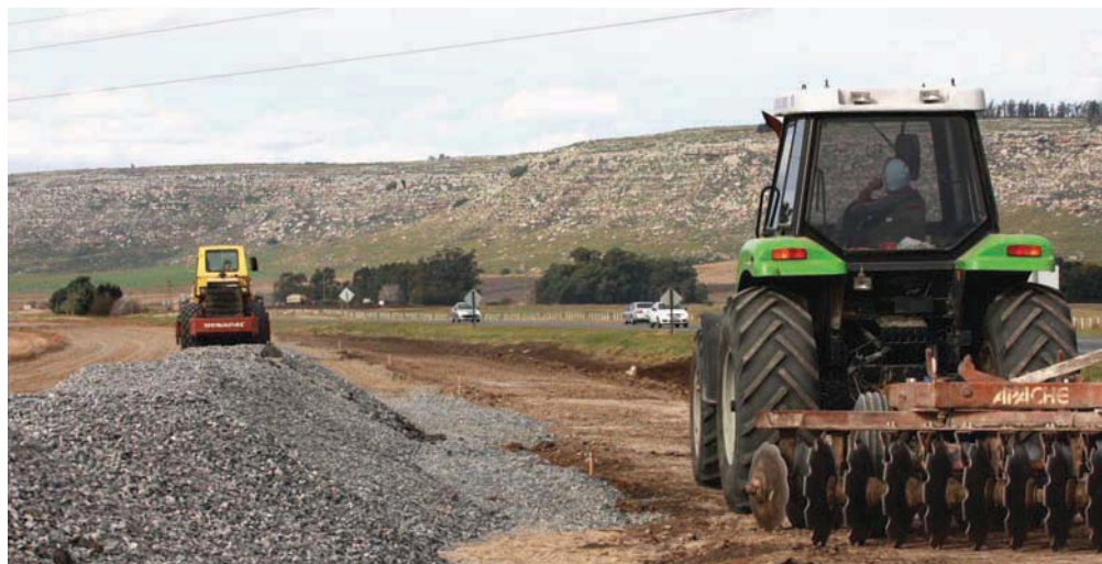
Duplicación. Se construye la segunda calzada hasta el kilómetro 64,6.
