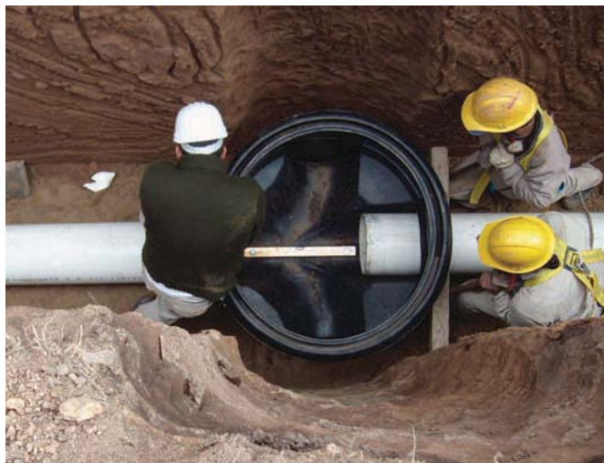
Colectores Cloacales. Las obras avanzan.
