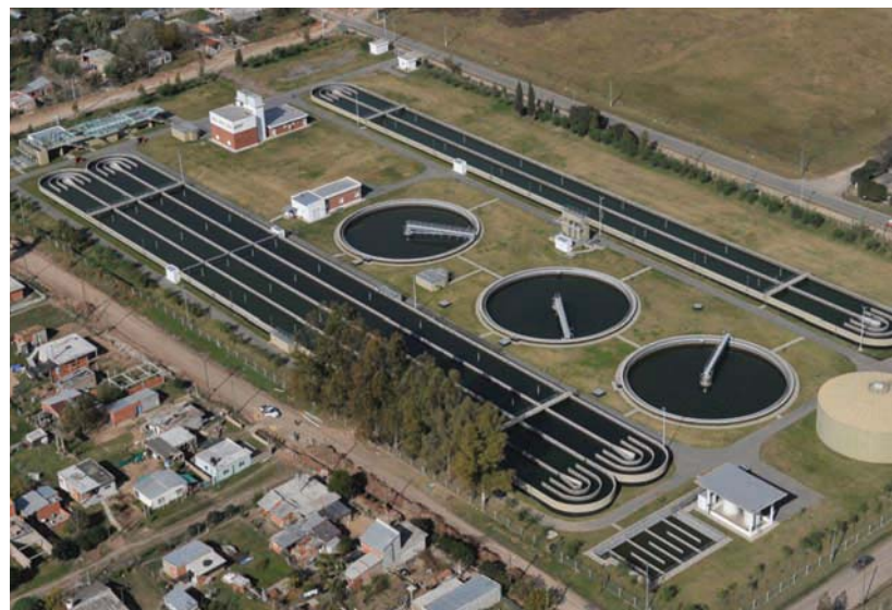
Moreno. Nueva Planta de Tratamiento de líquidos cloacales y redes colectoras y colectores en la localidad de Las Catonas.
