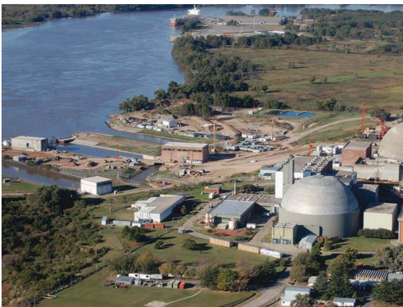
Atucha II. Sobre la margen derecha del Río Paraná, en Lima. Atucha II situated on the right bank of Paraná River, in Lima.
