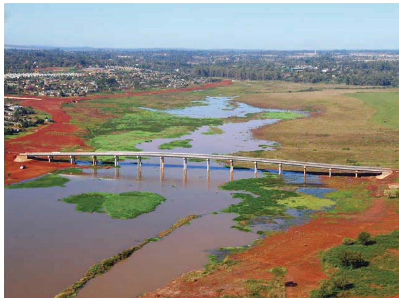
A° Mártires. Puente de acceso Oeste.
