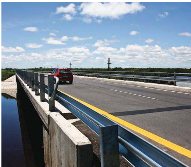
Puentes. La obra contempla la ejecución de 70 nuevos puentes.
