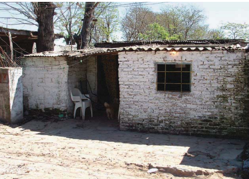
Viviendas precarias. Villa Palito antes de la intervención.
