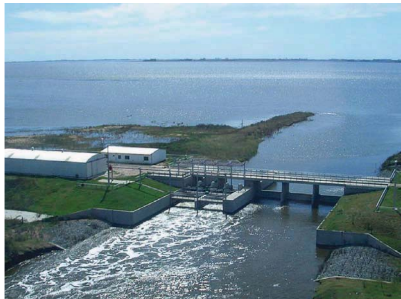
Impacto. El Plan de Obras amplía la superficie productiva y reduce las inundaciones.
