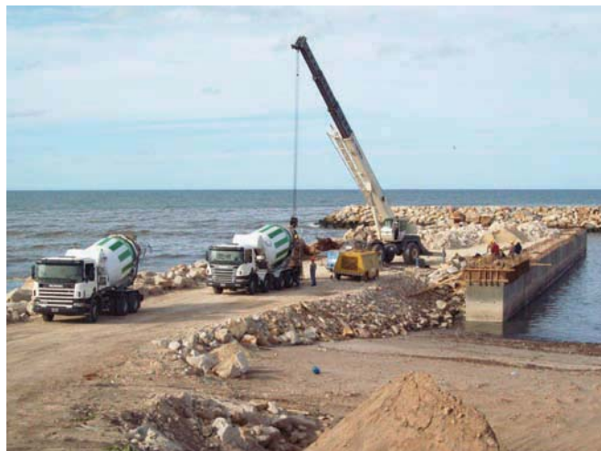
Avance de las obras. El trazado es perpendicular a la costa.
