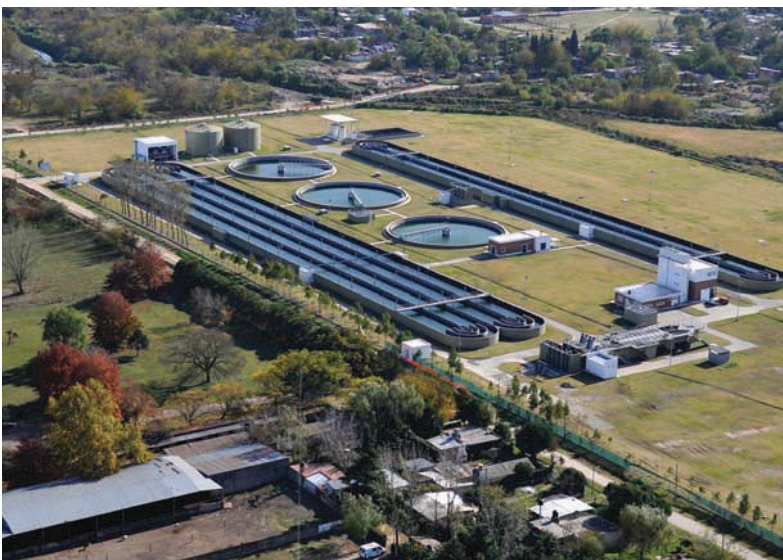
Merlo. Nueva Planta de Tratamiento de líquidos cloacales y redes colectoras y colectores en la localidad de Agustín Ferrari.
