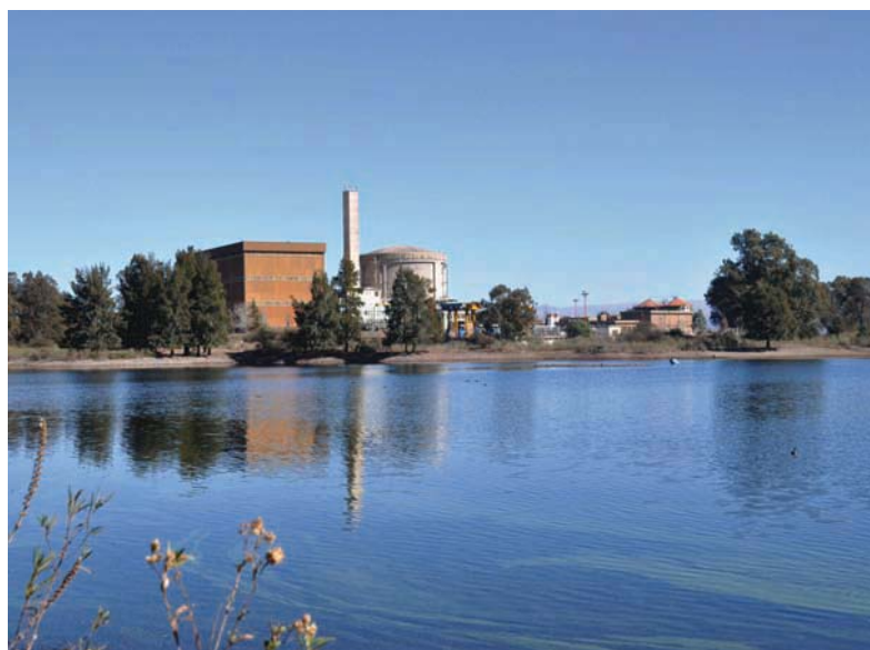
Embalse Nuclear Power Plant. In the south of Embalse de Río Tercero, Córdoba.
