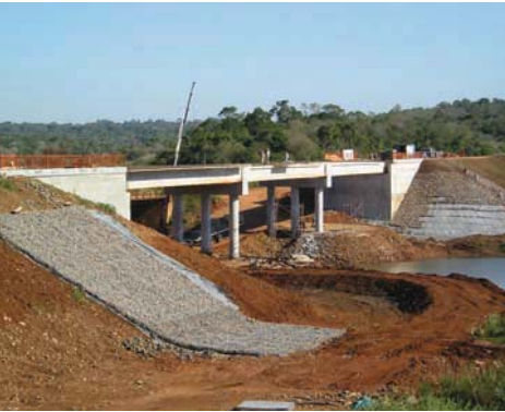
Puente de Ñacanguazú. Obras de urbanización.
