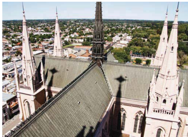
Segunda Etapa. La recuperación integral del techo de la Basílica se completó en la segunda etapa constructiva.
