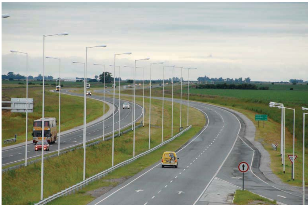
Curva Oncativo. Modernos sistemas iluminarán cruces y distribuidores.
