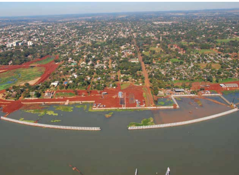
Bahía El Brete. Obras de protección y tratamientos costeros.
