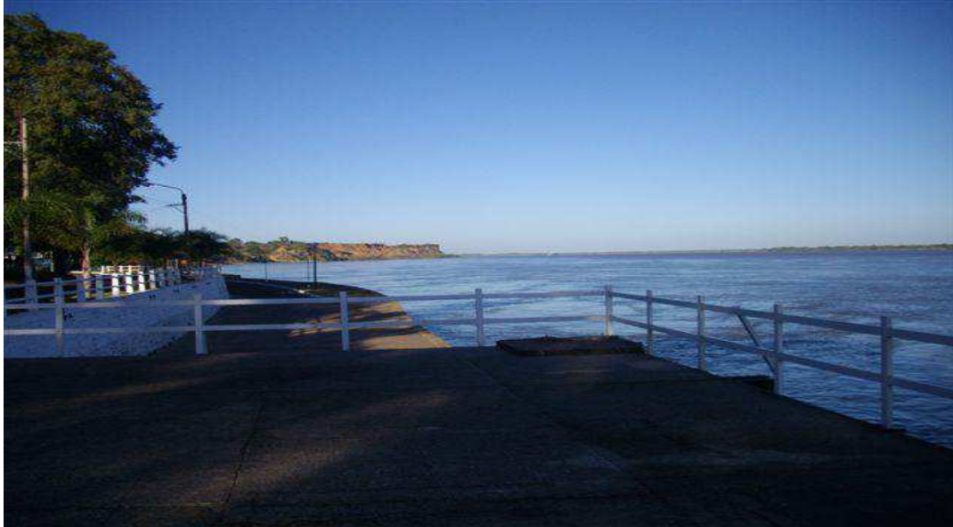
Explanadas del muelle actual del puerto de Bella Vista
