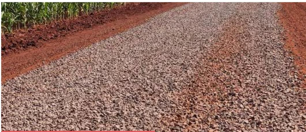
Figura 24. Revestimiento primario con piedra triturada
