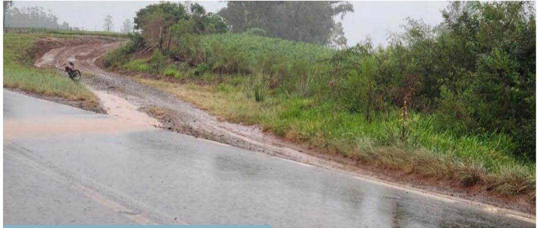
Figura 19. Sistema de drenaje superficial inexistente
