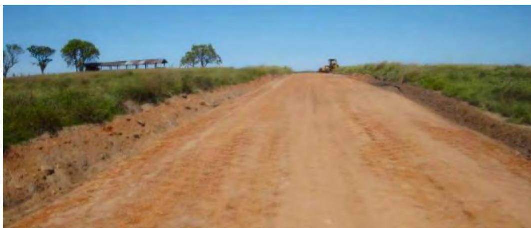
Figura 32. Mezcla de arcilla laterítica con grava en secciones experimentales
