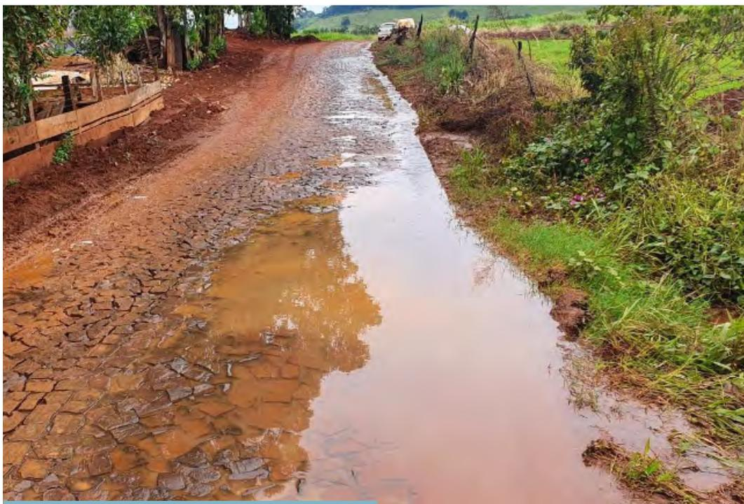
Figura 11. Drenaje inadecuado y plataforma estrecha
