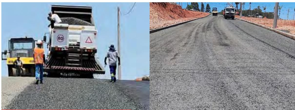
Figura 42. Ejecución de TSD con multidistribuidor
