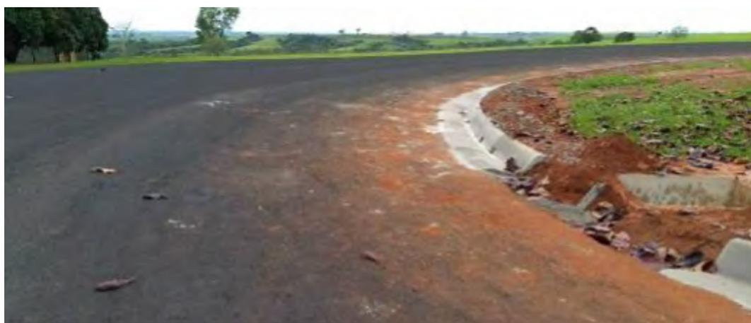
Figura 18. Sistema de drenaje superficial adecuado
