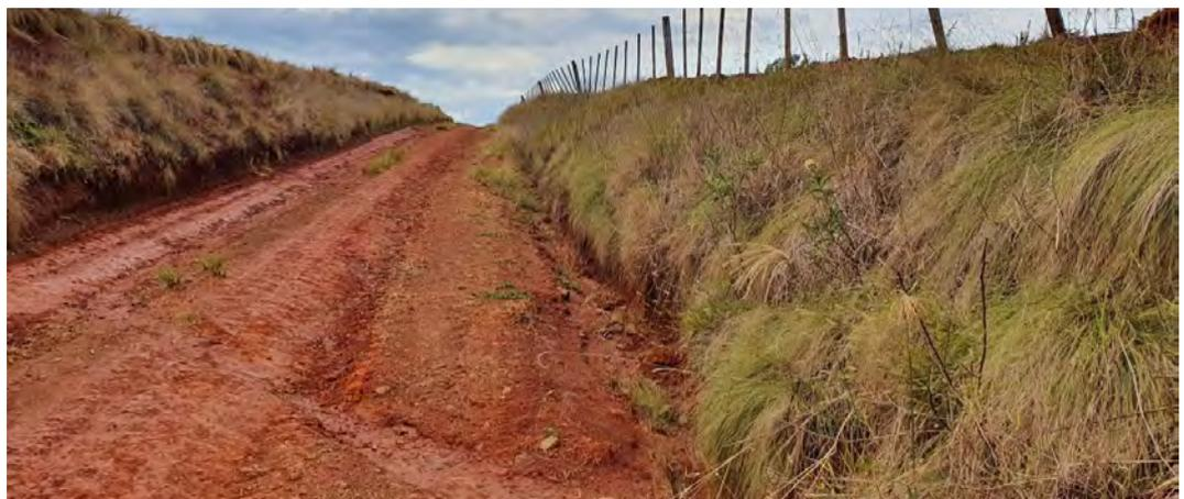
Figura 20. Sistema de drenaje superficial inadecuado
