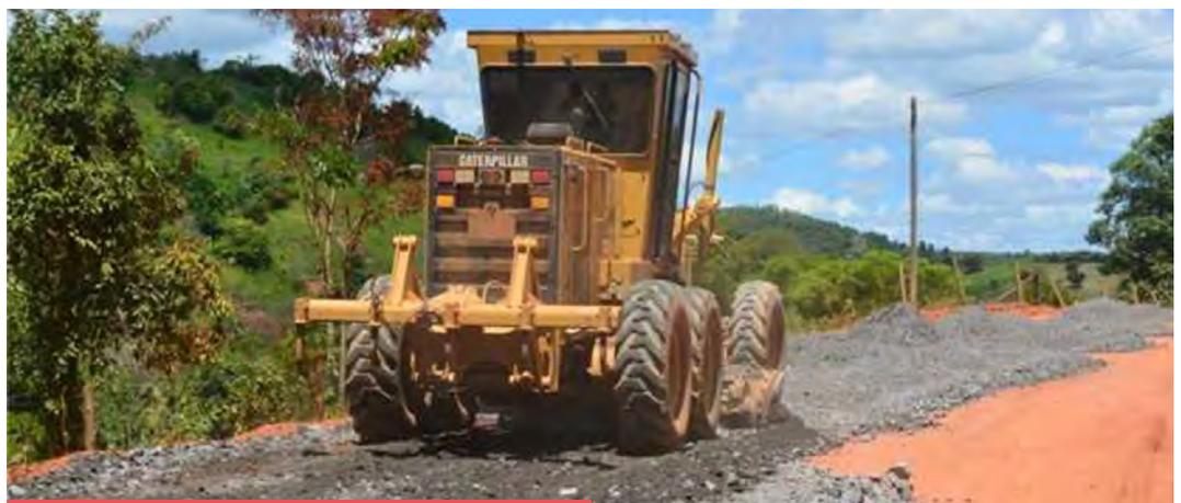
Figura 35. Revestimiento primario en acero. Alpercata - MG
