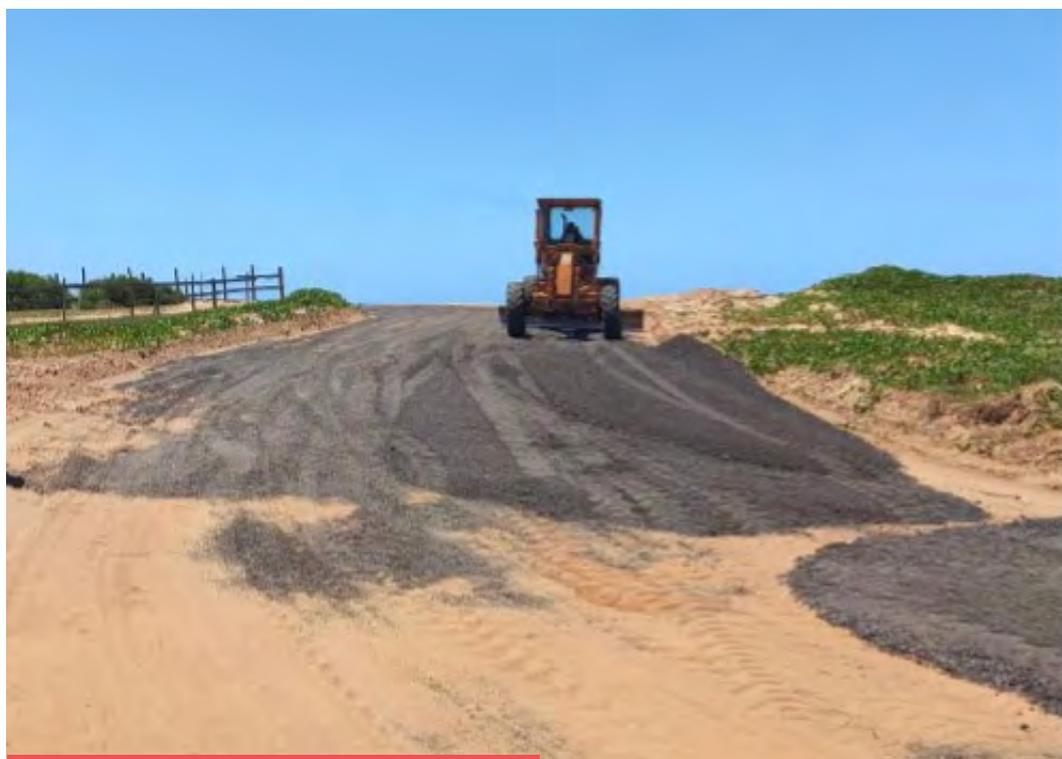
Figura 38. Recubrimiento con freado. Campos (RJ)
