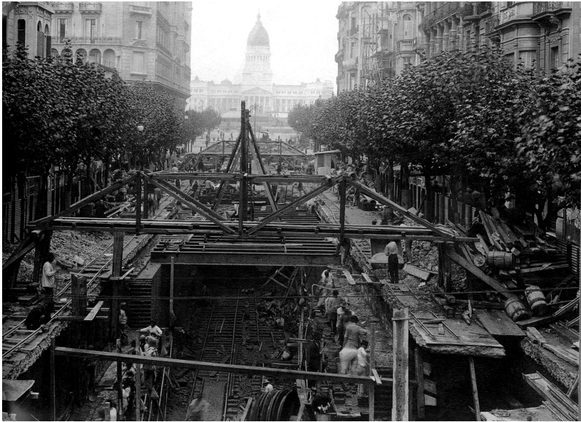
Subterráneo Línea A en construcción. Buenos Aires.
