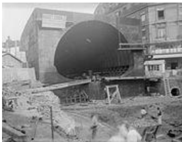
Construcción de una de las primeras líneas
