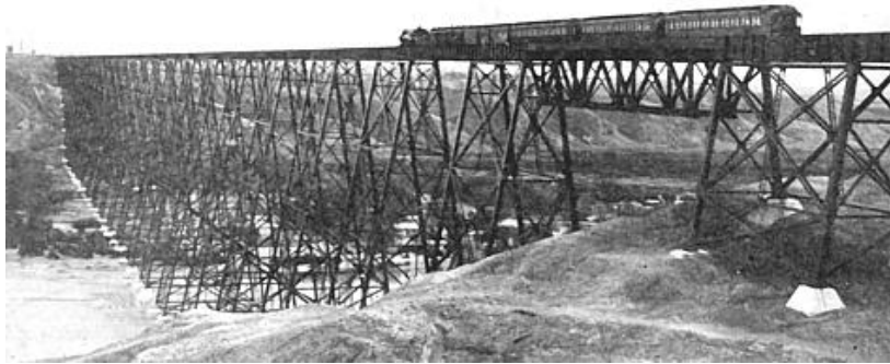
Canadian Pacific. Tren cruzando el viaducto de Lethbridge, de 1622 metros de acero a través del valle de Alberta, en la línea de paso del Nido de Cuervo.
