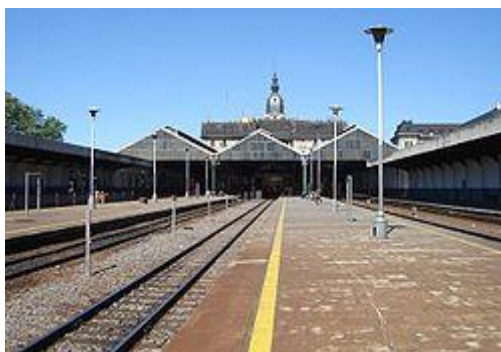
La estación Retiro del FCGMB
