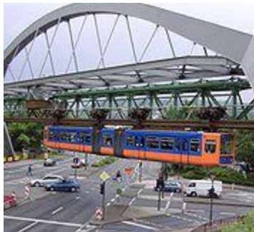
Schwebebahn Wuppertal, el primer monorraíl suspendido del mundo
