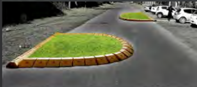
Dispositivo para reducir la velocidad por desvío de los vehículos Modelo 2x40-100 Medidas del módulo: Largo 25cm - Ancho 40cm - Altura 10cm Modelo 3x200 Medidas del módulo: Largo 1,20m - Ancho 15cm - Altura 10cm
