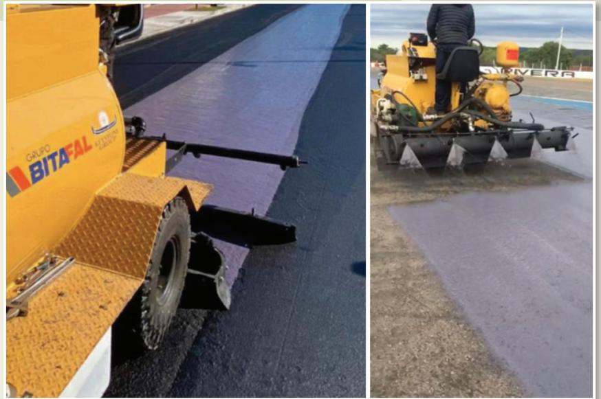
Figura 3. Aplicación de Seal Coat con lampazo (izq) y por aspersión (der)
