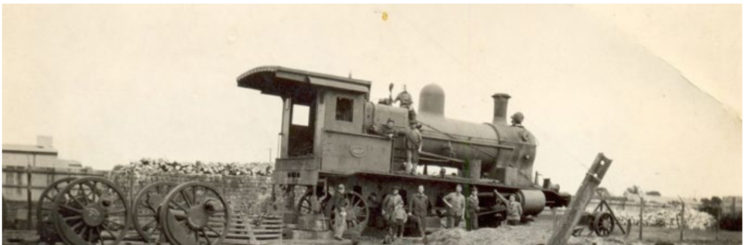
Una Clase 11 en reparaciones al aire libre en 25 de Mayo.
