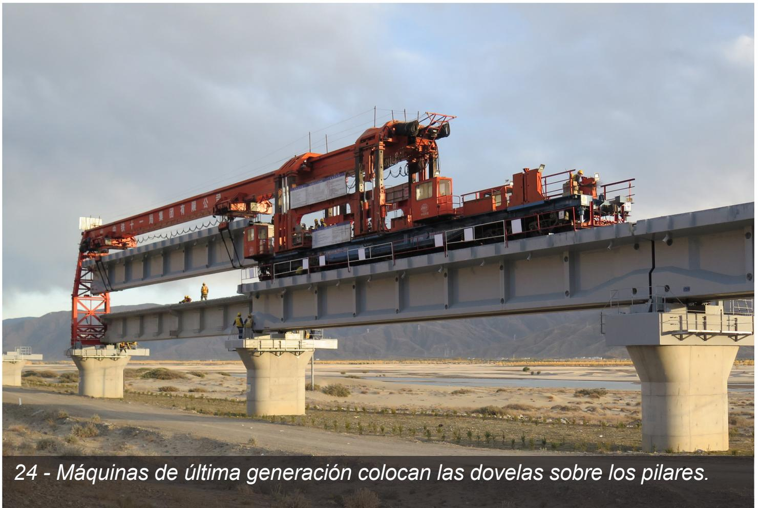
24 - Máquinas de última generación colocan las dovelas sobre los pilares.
