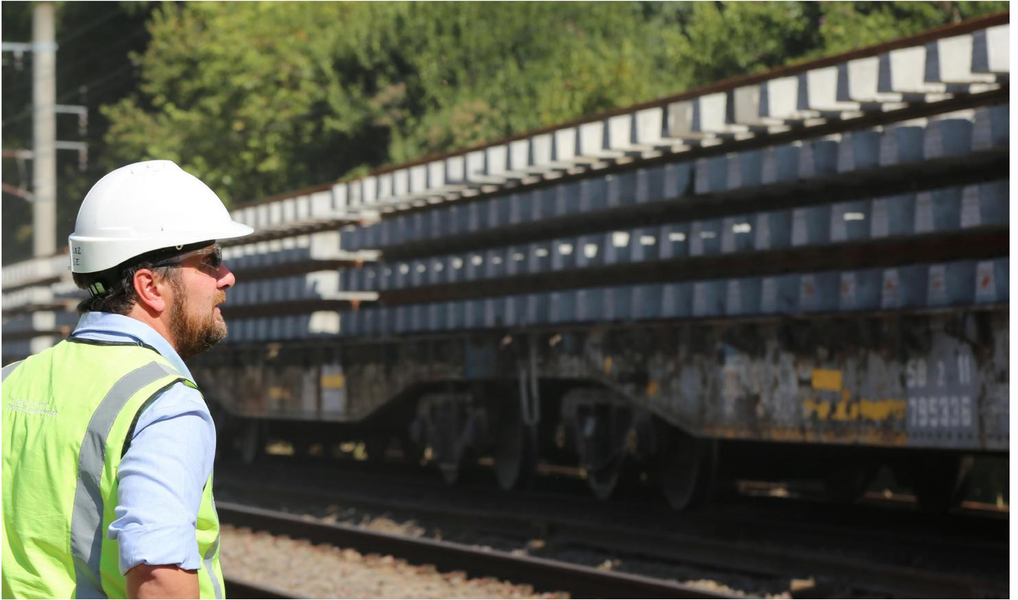
Comenzó la obra de renovación de 12 kilómetros de vía en la línea Roca, entre Glew y Alejandro Korn. Los trabajos incluyen el recambio de durmientes de quebracho por durmientes de hormigón y el reemplazo y colocación de vía nueva en sentido hacia Alejandro Korn (vía descendente). Se renovarán también cinco pasos a nivel, desagües, alcantarillas y vías en los cuadros de estación de Glew, Guernica y Alejandro Korn.
