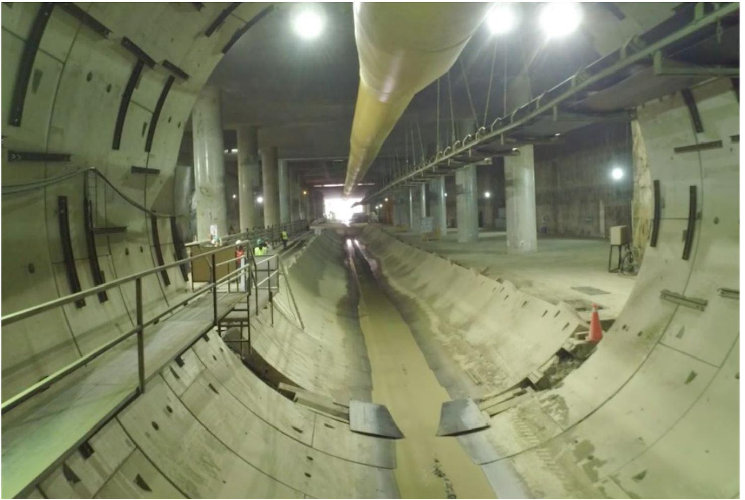
ción contenido bajo la presión de tierras que ejerce de la misma tuneladora y ponen el revestimiento definitivo dentro del propio escudo metálico de la tuneladora. Esto es importante tanto para los operarios que trabajan bajo tierra como para los usuarios de superficie y la conservación de los edificios, teniendo en cuenta que la Línea 1 pasa por debajo del Centro histórico de la ciudad.
