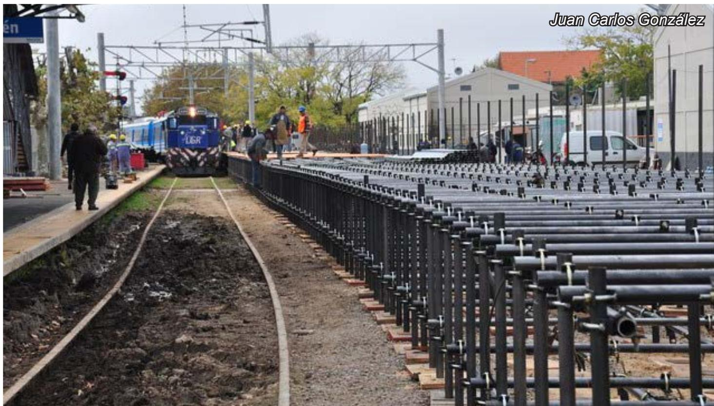
Se siguen llevando a cabo las tareas de readecuación de estaciones por el nuevo servicio electrificado de la Línea Roca. En este caso ofrecemos estos registros de cómo se llevan a cabo las tareas de elevación de plataformas provisionales en la Estación Berazategui del ramal a La Plata y a Bosques (Vía circuito).
