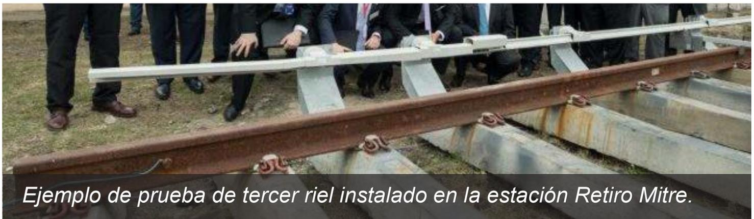
*Ejemplo de prueba de tercer riel instalado en la estación Retiro Mitre.*
