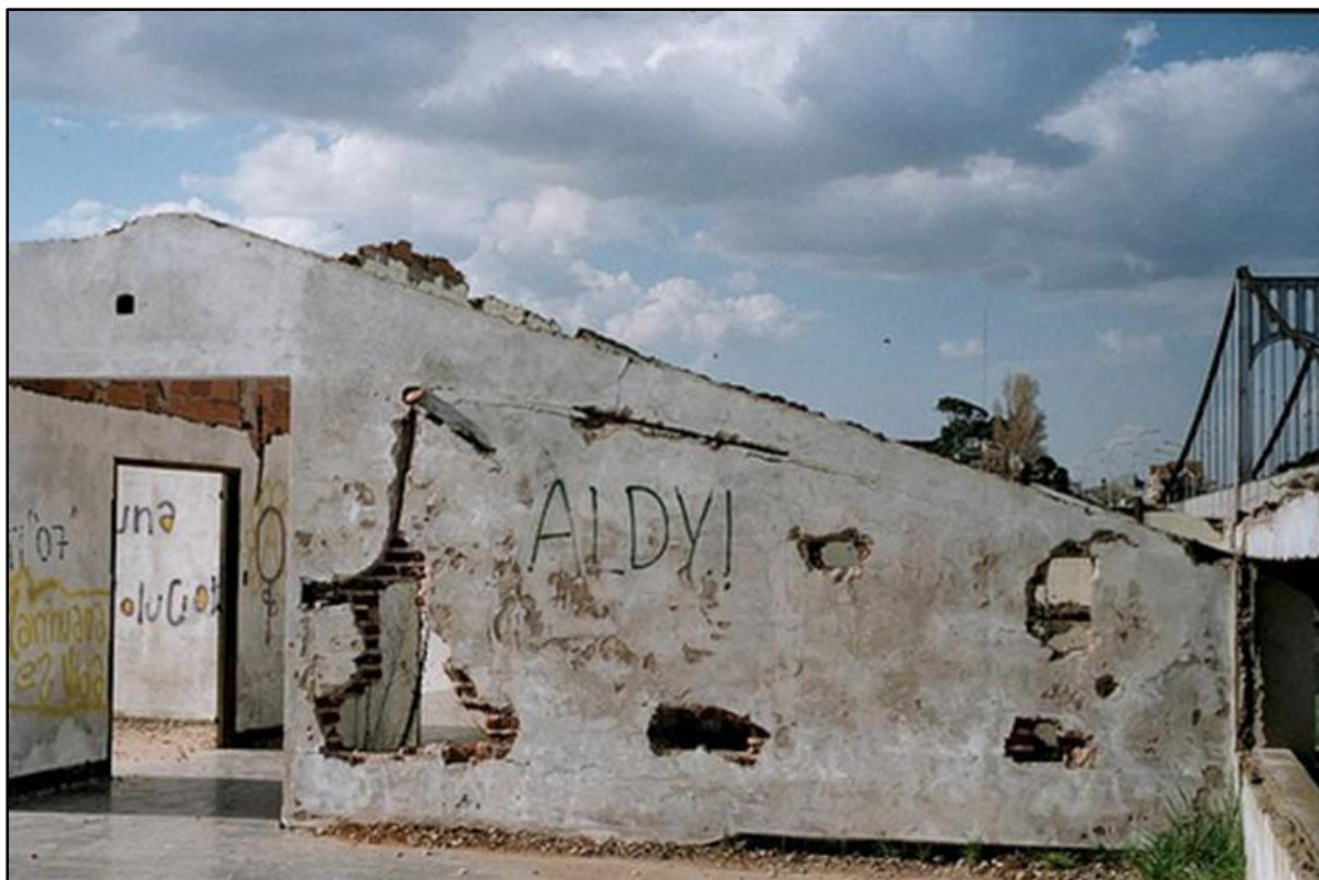
Foto nº 1. Vista desde el lado de Quequén al Puente Colgante. Octubre de 2008.
