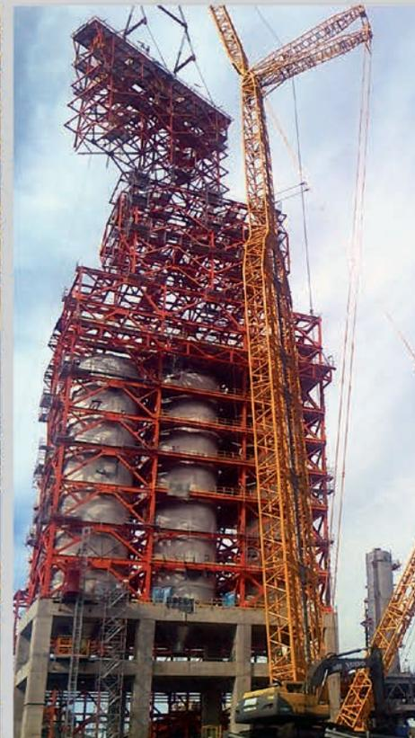
**CINTER ha fabricado alrededor de 5.000 Tn de estructuras metálicas para la construcción de las nuevas Cámaras de Coque de YPF S.A. en La Plata . Esta gran estructura alcanzó una altura final de 120 mts.**
