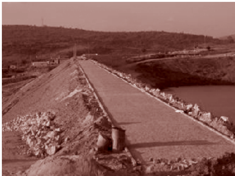
Foto 6. Construção da barragem de Jandaia – Bananeiras
