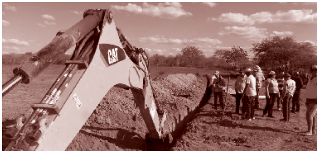
Foto 5. Programa de construção de barragens subterrâneas
