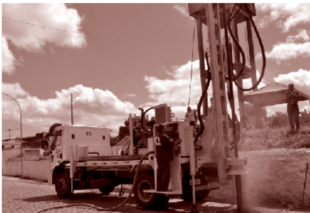
Foto 3. Perfuração e recuperação de poços na Paraíba
