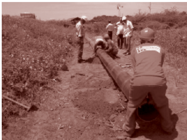
Foto 9. Programa de construção de adutoras de engate rápido
