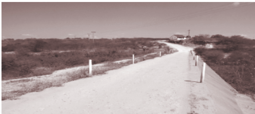
Foto 2. Barragem Veneza, no município Quixeramobim (CE), em 2015
