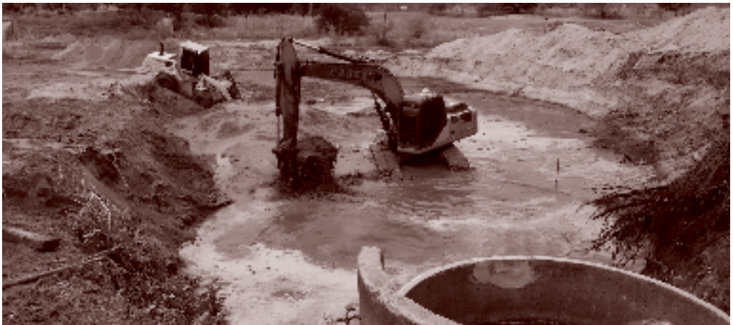
Foto 5. Perfuração de poço de Jacó no leito do rio Banabuiú, na Comunidade Inharé, em Senador Pompeu (CE)
