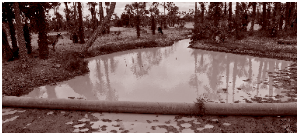
Foto 2. Adutora de Montagem Rápida
