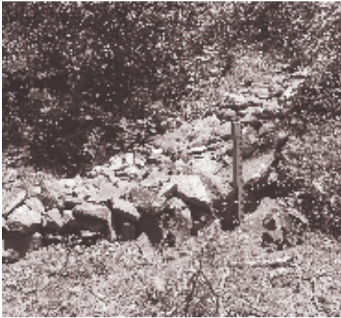
Foto 1 - Barramentos e cordões de pedra – recuperação de solo, água e biodiversidade
