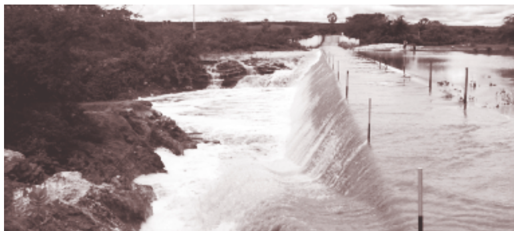
Foto 1. Barragem Veneza, no município Quixeramobim (CE), em 2008
