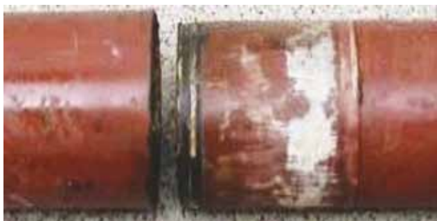
Figura 25. Muestra 1, posensayo. Separación de la junta.
