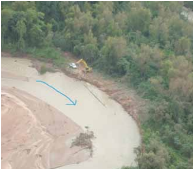
Figura 18. Destape del gasoducto aguas arriba del cruce.
