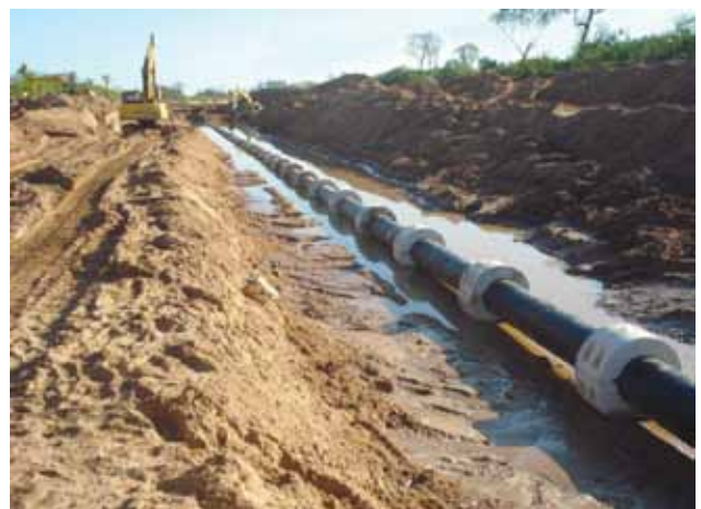
Figura 21. Operación de bajada y posterior contrapesado.
