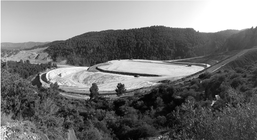
FIGURA 8 | La escombrera vieja de Cardona en proceso de restauración (2017)
