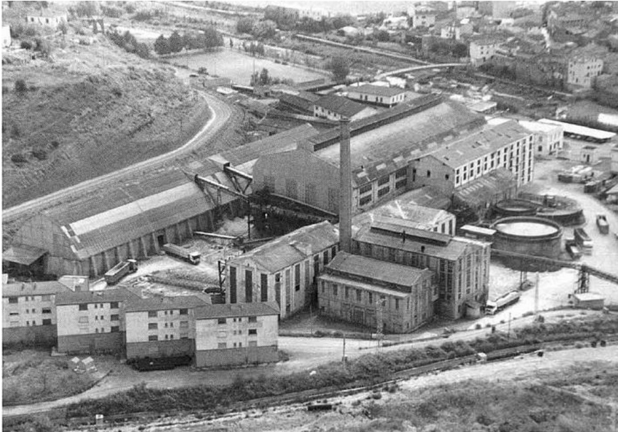
FIGURA 4 | Fábrica de cloruro potásico de la mina Nieves, en funcionamiento desde 1926, situada en el barrio de La Coromina
