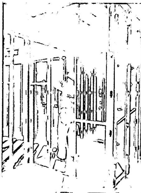
Instalación de la estructura metálica, nótese los refuerzos horizontales alternados y los crificios en los montantes destinados al paso de cañerías.
