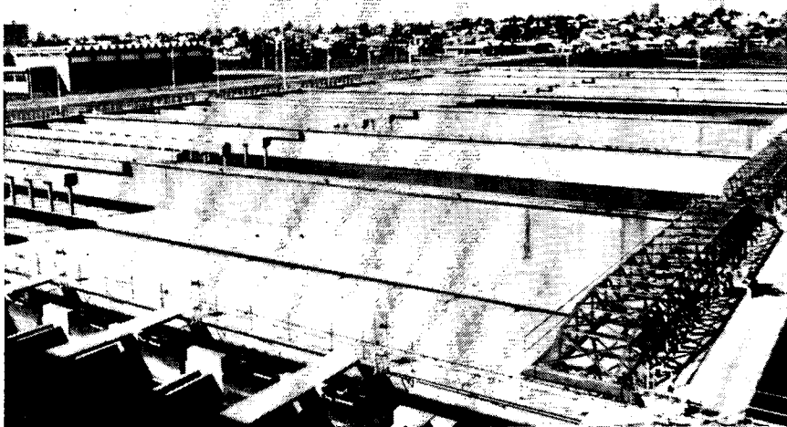
Decantadores del Establecimiento Potabilizador de Bernal, provincia de Buenos Aires.
