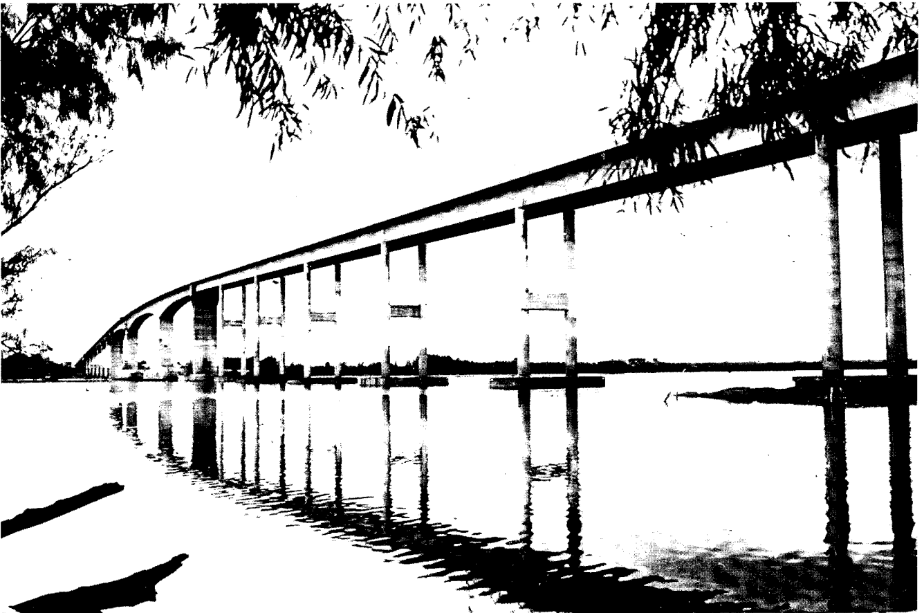
Puente Internacional Colón - Paysandú
