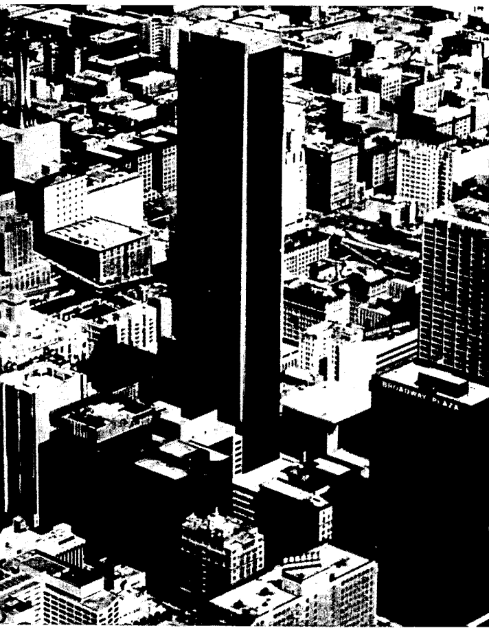
Edificio en el que funciona la Agencia del Banco de la Provincia de Buenos Aires en Los Angeles, EE. UU.
