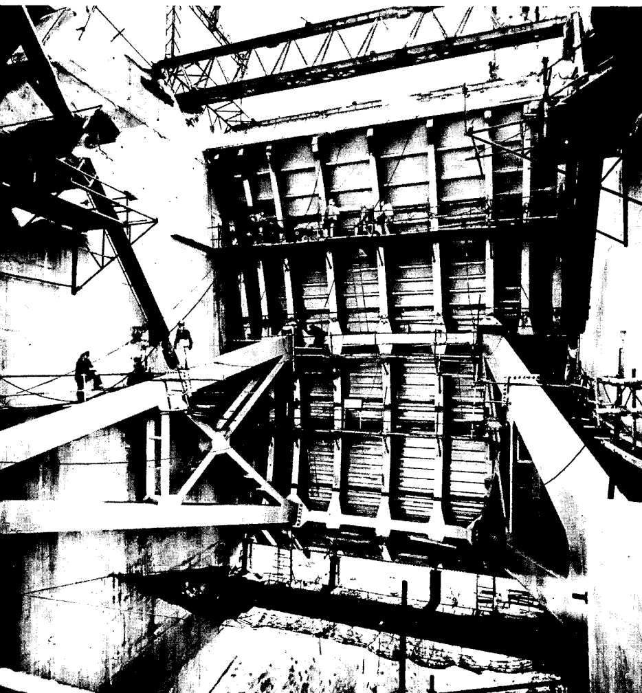
Compuertas radiales para centrales hidroeléctricas.
