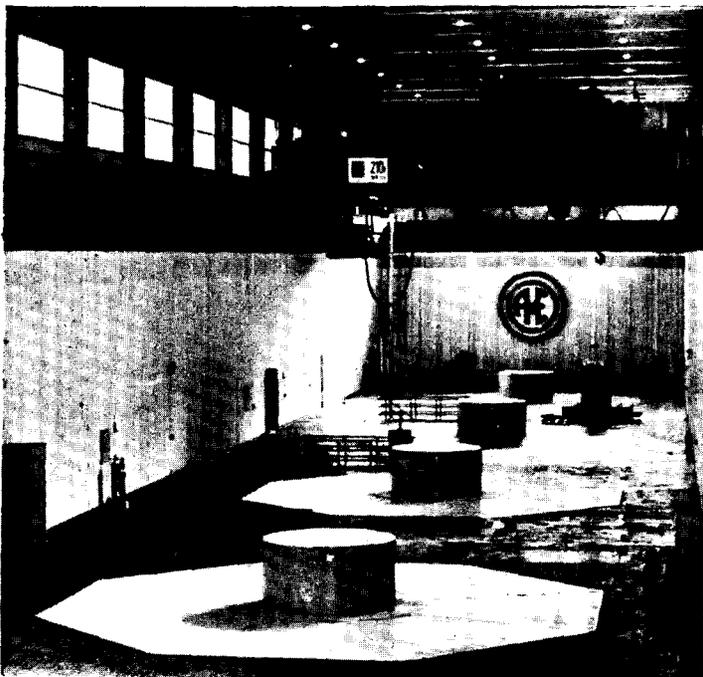
Interior de la Casa de Máquinas, donde pueden verse las 4 turbinas allí instaladas, de 112.000 Kw cada una.
