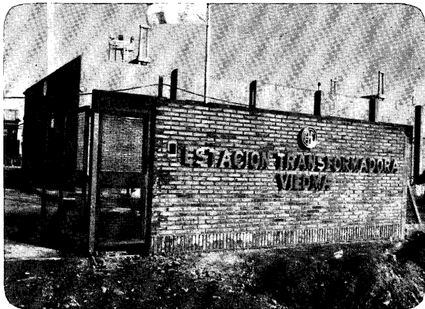
Edificio de la Estación Transformadora Viedma, recientemente inaugurada. Permitirá un importante ahorro de combustibles líquidos.
