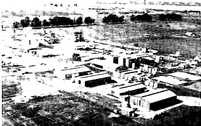
Vista panorámica de la planta de poliúres de la empresa Indoquín S.A., en Puerto San Martín, provincia de Santa Fe.
