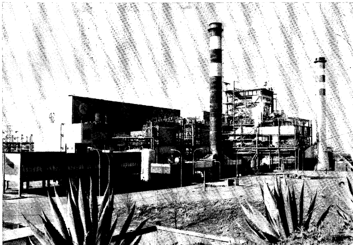
Central Térmica Luján de Cuyo, en la provincia de Mendoza
