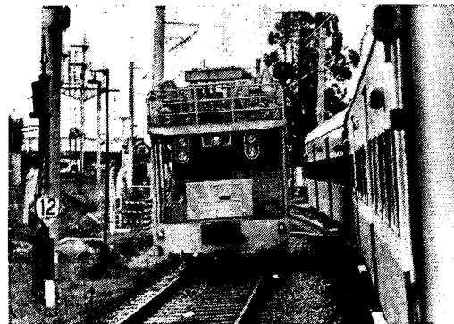
Uno de los equipos usados en la electrificación.
