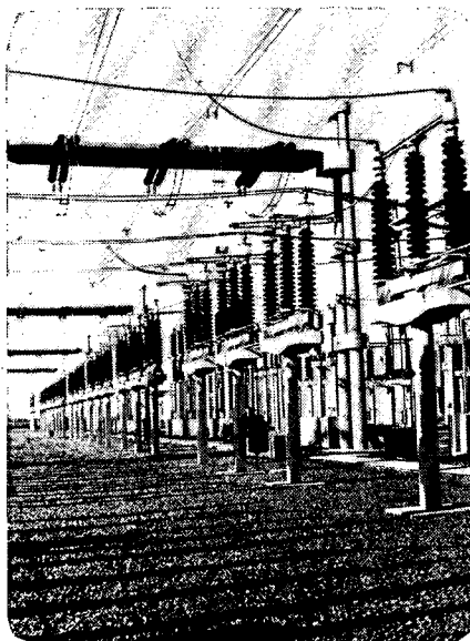
Más obras para generación y transmisión de electricidad.
