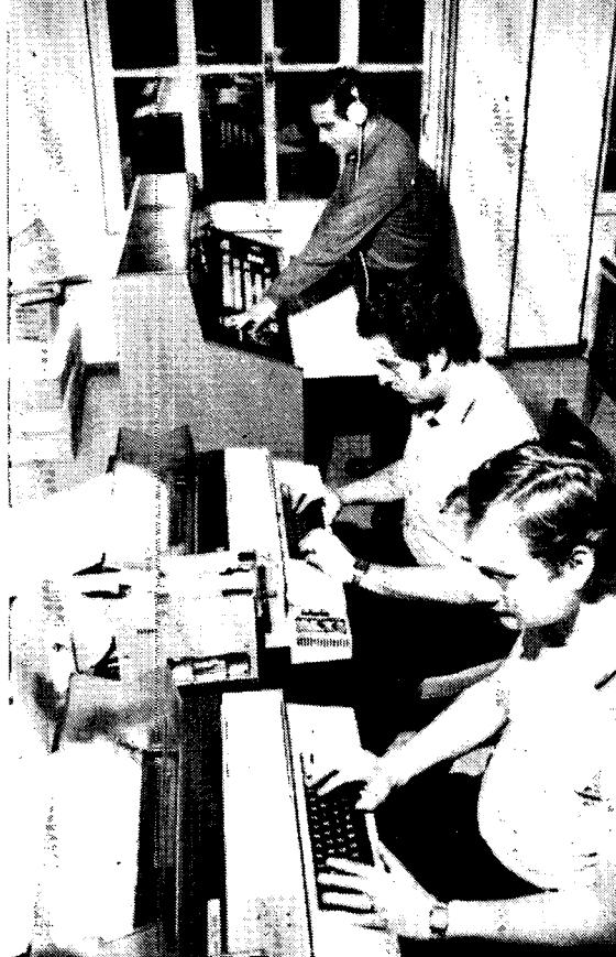
Equipos de prueba de una central telefonica automatica.
