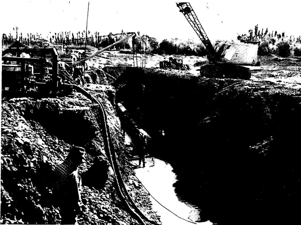
*Trabajos de instalación del gasoducto Neuquén-Bahía Blanca, con revestimiento de hormigón en su cruce del río Neuquén.*
