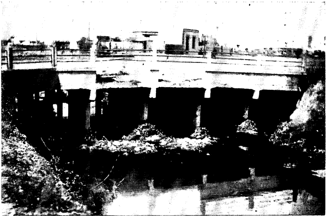
La multiplicidad de tareas del Ente Autónomo de Industria Municipal abarca, también, la realización de obras viales importantes como puede apreciarse por este puente construido sobre el arroyo Cildáñez
